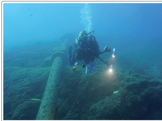
Abb. 4: Datenerfassung am Untersuchungsobjekt »Abwasserrohr«
