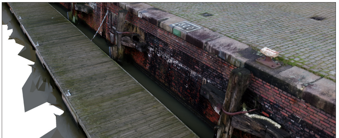
Abb. 3: Ergebnis einer Kaimauerinspektion mit Überflügen in drei unterschiedlichen Höhen, dargestellt mit RealityCapture
