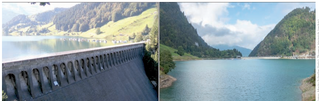
Abb. 1: Staumauer Schräh, links die Luftseite, rechts die Seeseite mit Blick auf die Mauer
